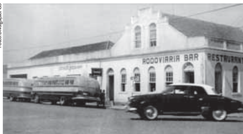
Antiga Estação Rodoviária, que ficava na Rua Tenente Coronel Brito, em área central
