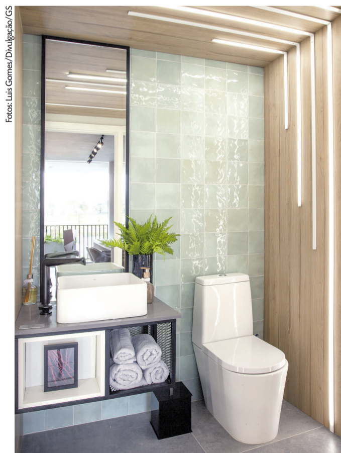
No lavabo o revestimento cerâmico é marcado pela uniformidade de suas peças, o que simplifica o processo de paginação e instalação
