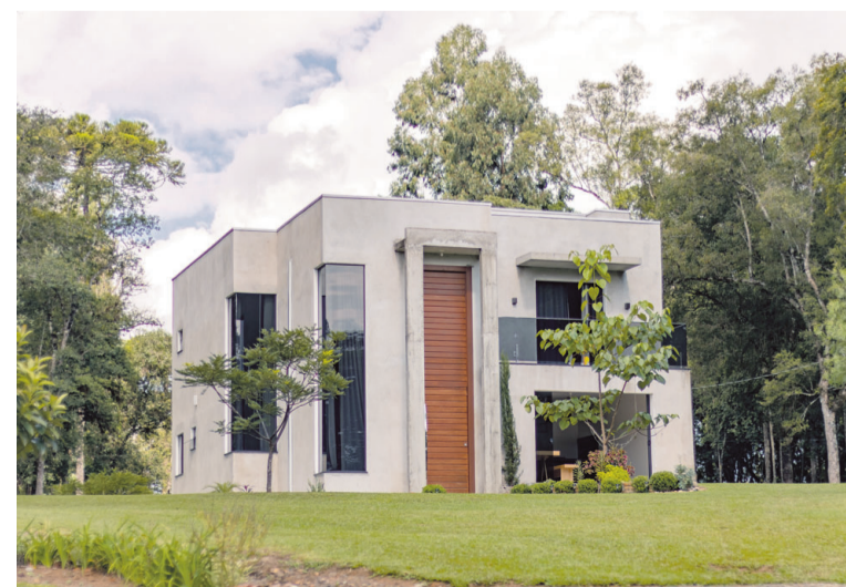
Casa do casal Josnei e Camila ganhou forma e vem sendo construída pelo produtor
