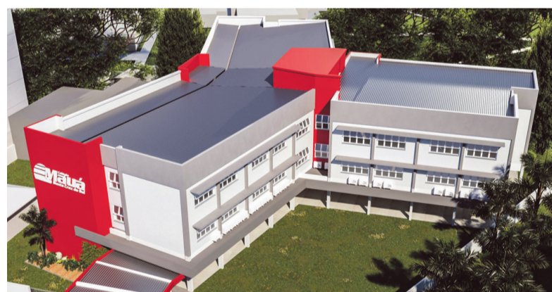
Novo prédio ficará localizado na Rua Conselheiro Augusto Henning
