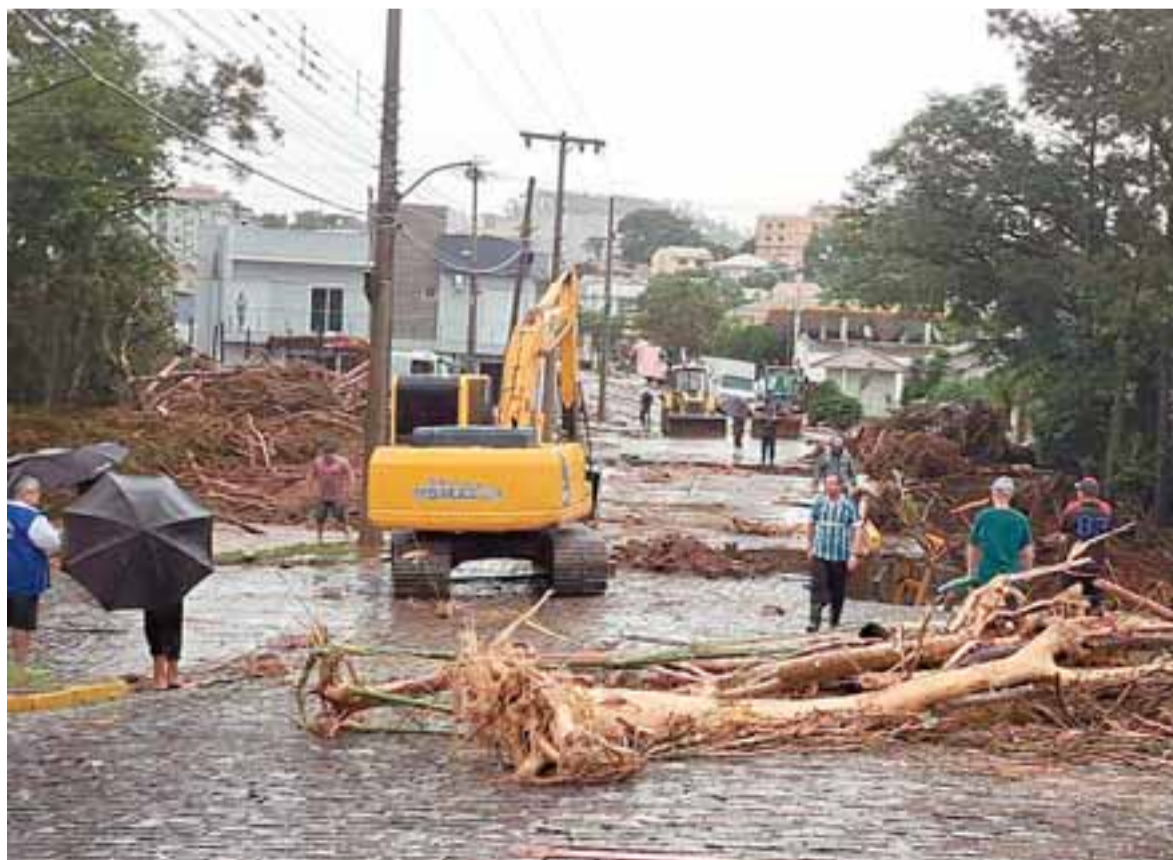
Maquinários estão sendo utilizados para desobstrução de ruas e estradas nas cidades e também em localidades do interior
