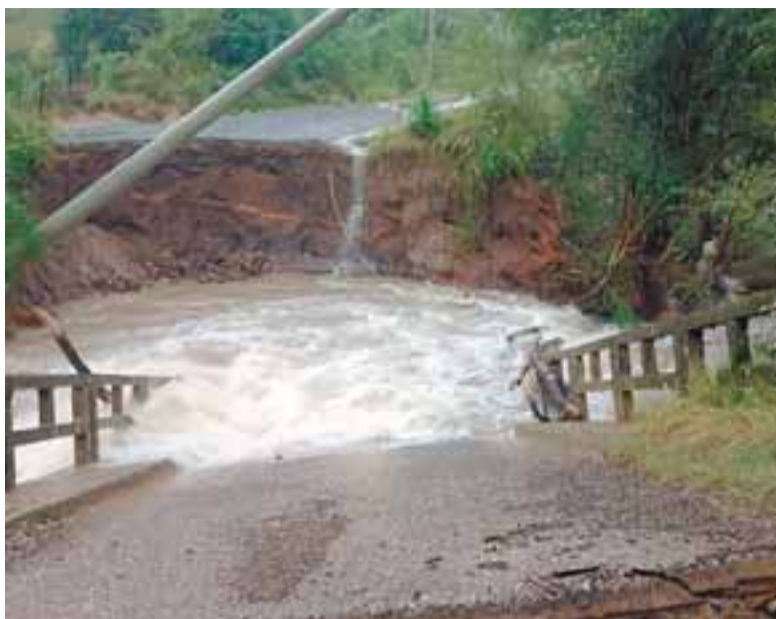
Forte correnteza destruiu ponte sobre o Rio Pardinho na divisa com Boqueirão do Leão
