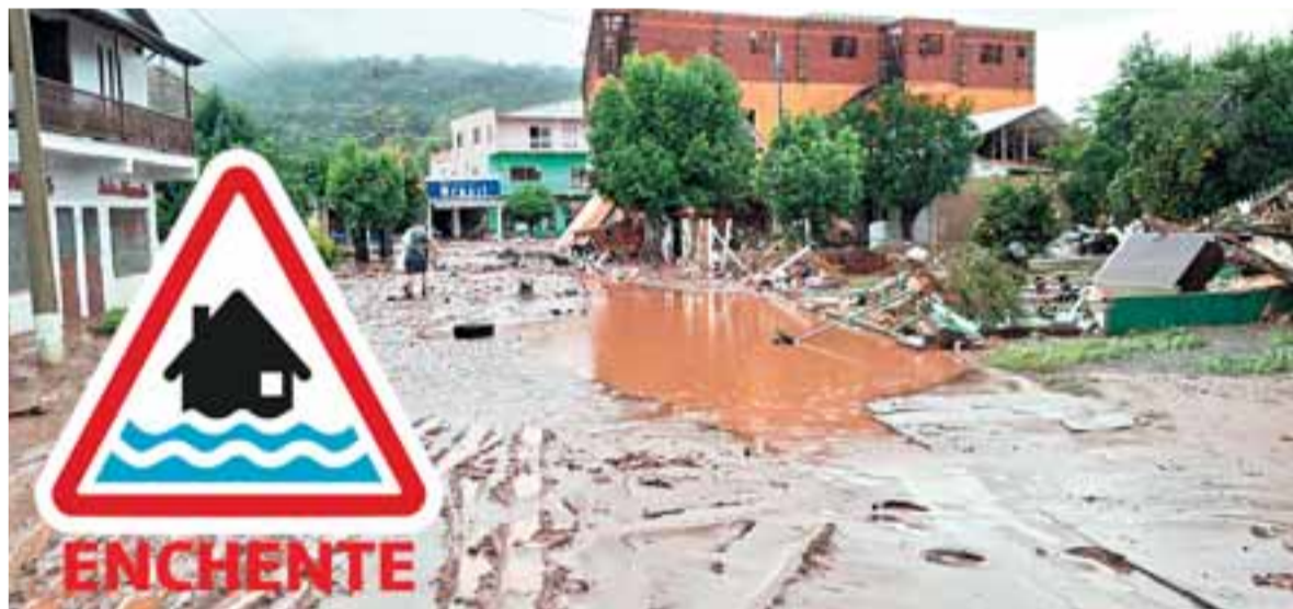
Um rastro de lama e grande quantidade de entulhos pode ser observado no centro do município, que foi varrido pela enxurrada
