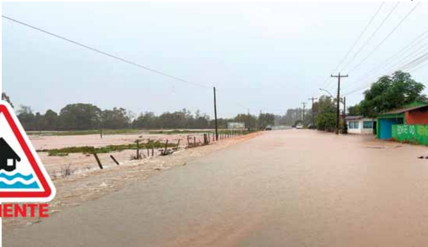
Levantamento aponta que 90% das estradas de Vale do Sol apresentam algum problema. Trabalhos agora buscam assegurar a recuperação das áreas mais críticas
