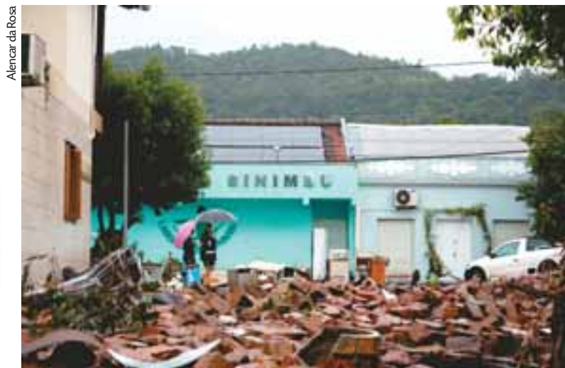
Equipes de voluntários continuam no trabalho de limpeza e remoção de escombros
