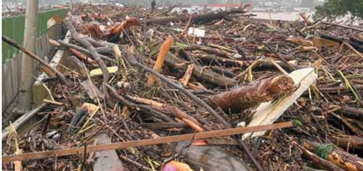
Em cima da ponte sobre o Rio Taquari, entre Estrela e Lajeado, o acumulado de galhos e entulho trazidos pelas águas impressiona
