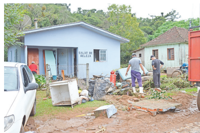
Outra residência com prejuízos em Ibarama
