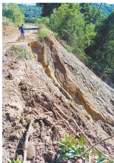
Deslizamento Cerro do Adão ligação entre Várzea Grande e Linha Alta Fundos
