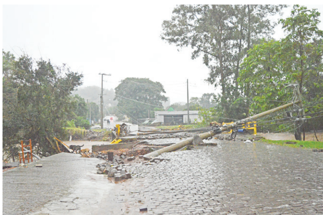
Ponte do Bairro Rio Branco (Apa), Sobradinho
