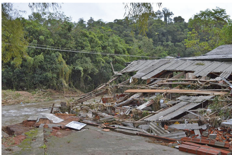
Acesso Eloy de Oliveira Brito teve casas totalmente destruídas
