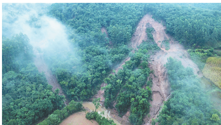
Deslizamento em Várzea Grande que liga a localidade de Arroio Grande
