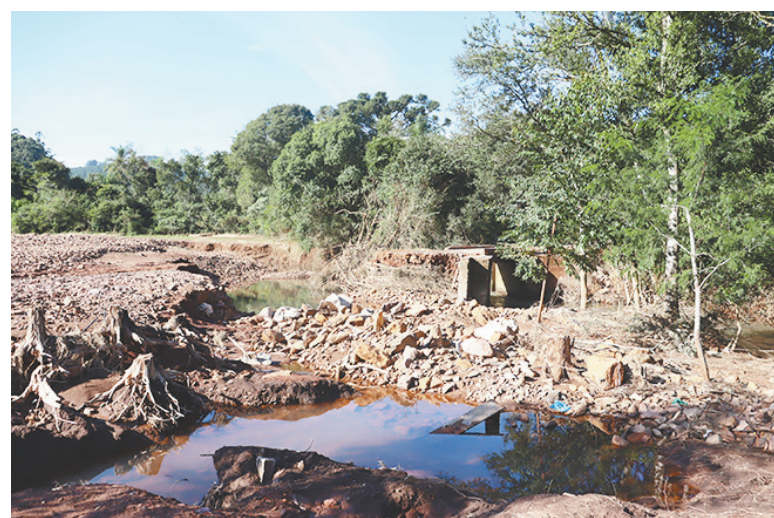
Ponte Travessa Pens - Várzea Grande
