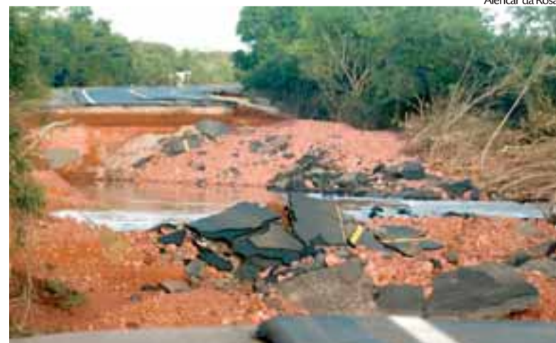
Em alguns trechos da RSC-287, em Venâncio Aires, força da água fez a pista desaparecer
