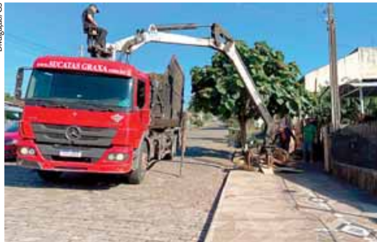
Material é retirado e empilhado ao longo das calçadas. Trabalho continua nesta semana
