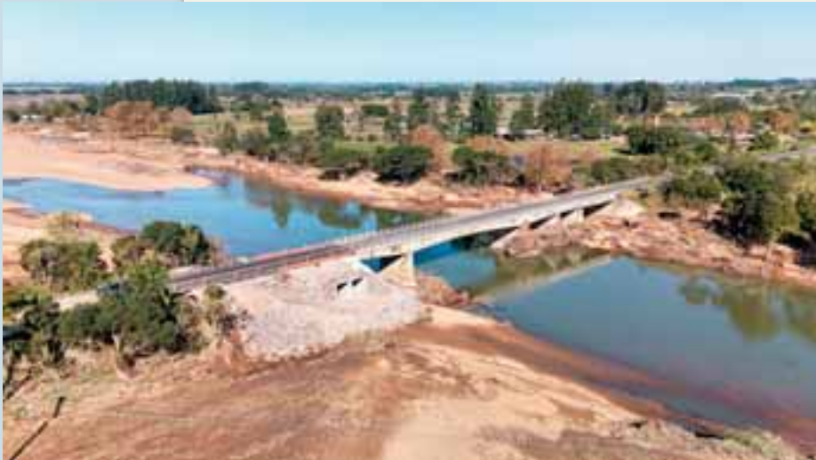
Ponte recebeu nova cabeceira, galerias e recuperação da pista danificada
