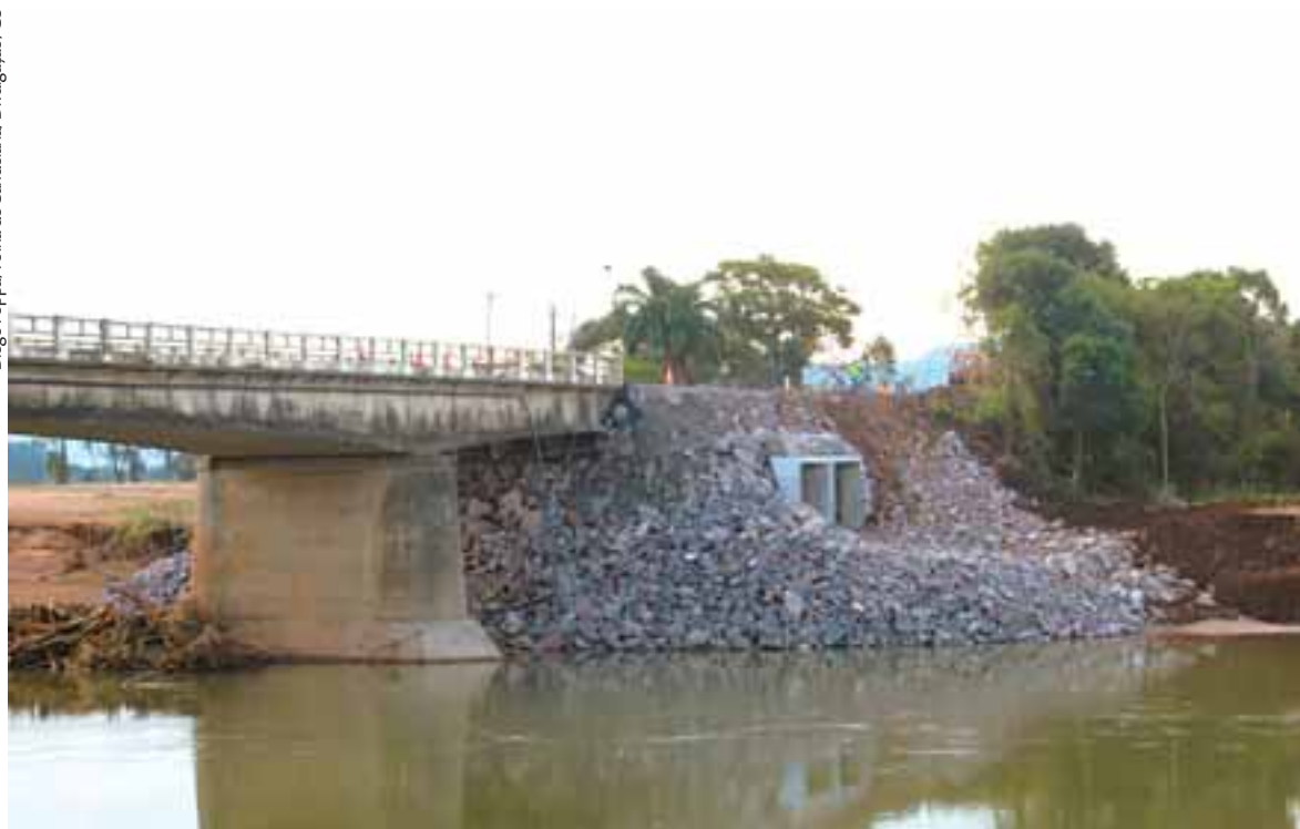
Em Candelária, estrutura perdeu uma parte da pista e também a cabeceira. Recuperação foi feita com pedras e uma nova galeria
