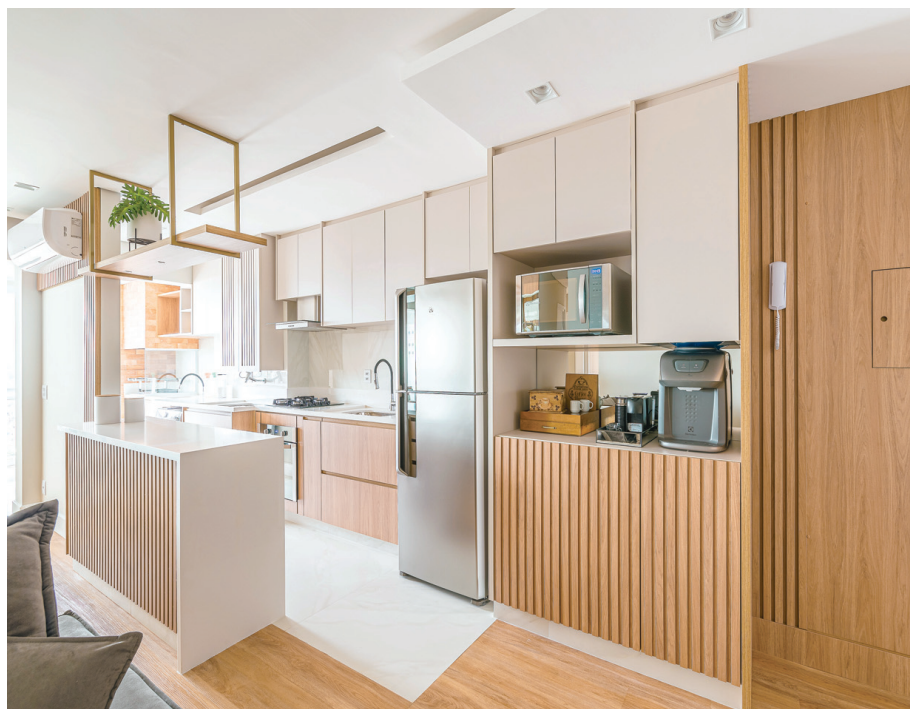
No projeto deste apartamento, criou-se uma transição harmoniosa entre o piso vinílico da sala e o porcelanato da cozinha. Para garantir segurança, foi necessário realizar o nivelamento durante a reforma, já que os dois materiais têm espessuras diferentes e poderiam gerar um pequeno desnível, aumentando o risco de acidentes
