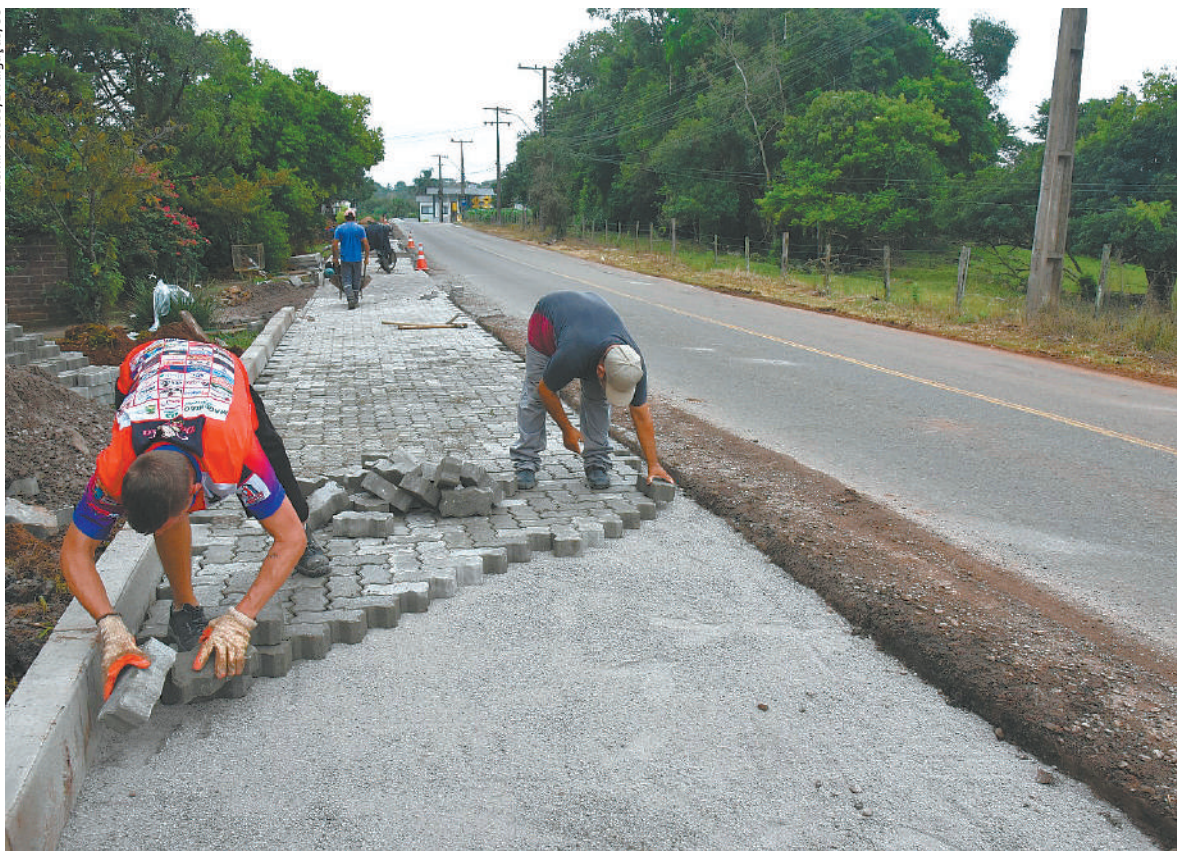
Obras no acostamento estão em andamento. Melhoria visa garantir mais segurança a pedestres e ciclistas que utilizam a via
