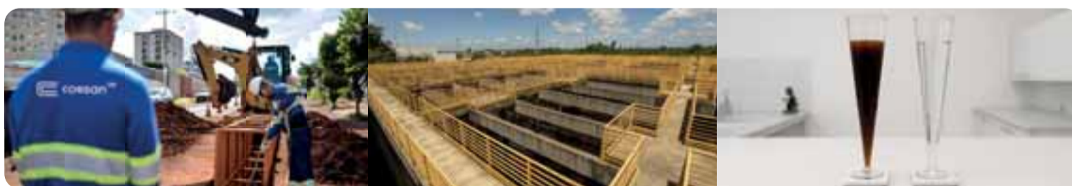
OBRA DE REDE DE ESGOTO
