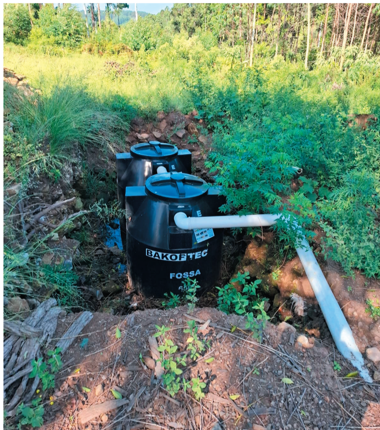
Fossas sépticas são instaladas a partir de mapeamento das propriedades rurais
